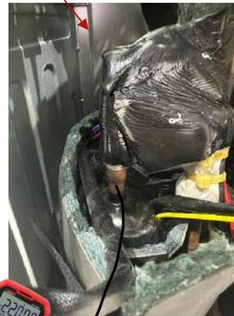
Messen Sie den Widerstand zwischen dem Stecker und dem Kompressorgehäuse.
